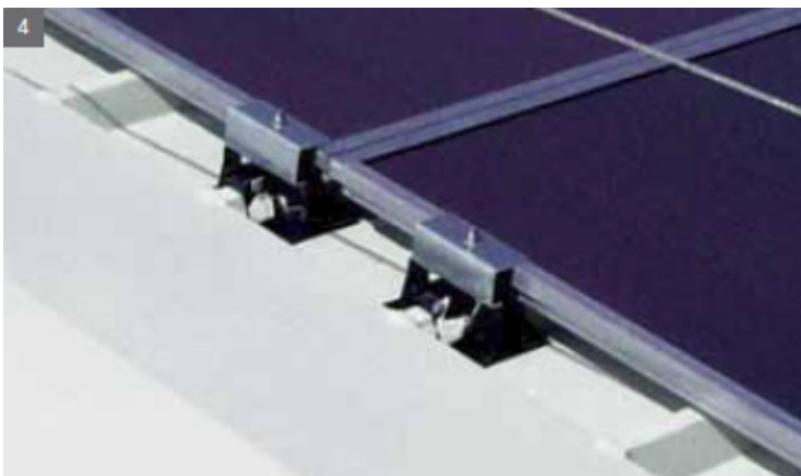
4. La ligne de strings est arrêtée en disposant les brides finales sur le périmètre. Le câblage intermédiaire de chaque ligne de strings, comme le raccordement de cette dernière au reste de l'installation, est exécuté et assuré avec les connecteurs photovoltaïques volants.
