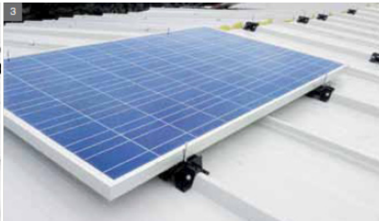
3. On commence donc à positionner les différents panneaux qui constituent les différentes lignes de strings photovoltaïques.
