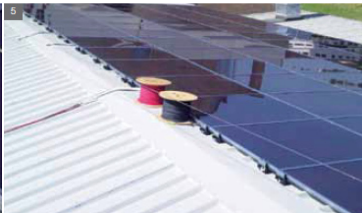
5. L'installation est finie et prête pour être raccordée à l'onduleur.
