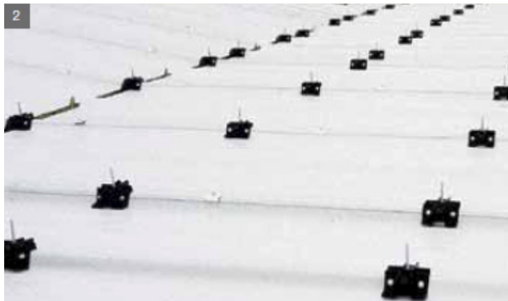
2. La présence des profils à la grecque assure un alignement facile et rapide des brides.
